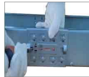
케이블 트레이와 무볼트 조인트 체결
